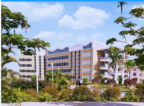
مبني الهندسة الكهربية والهندسة الكيميائية
